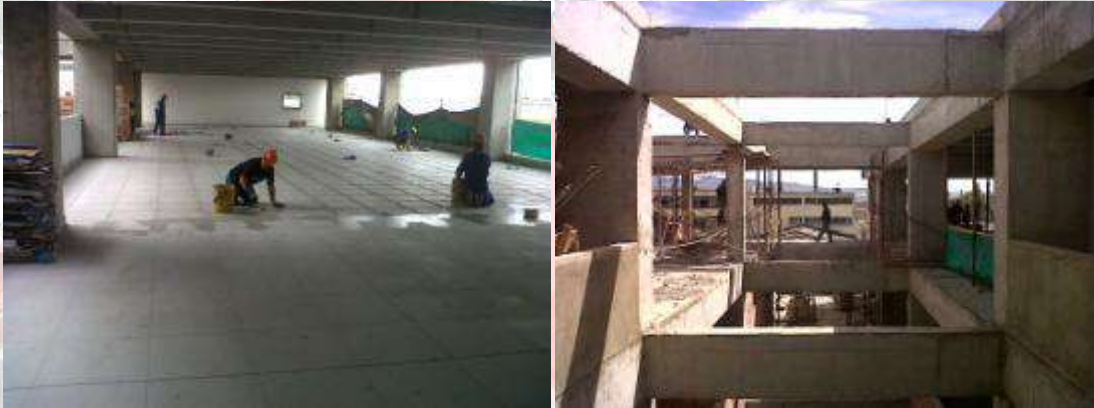
Foto No. 19 Avance de la Obra Comando
