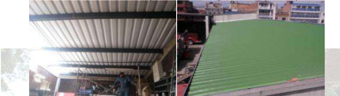
Foto No. 22 Cambio de cubierta y estructura área logística estación Restrepo
