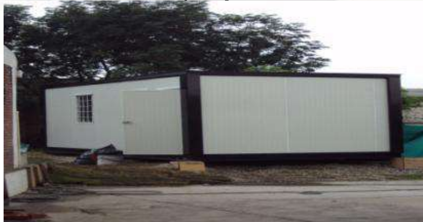
Foto No. 21 Contenedor tipo alojamiento Estación Bellavista
