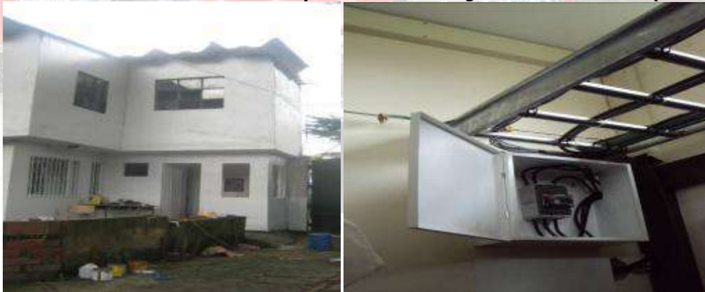
Foto No. 23 Cambio de cubierta y estructura área logística estación Restrepo
