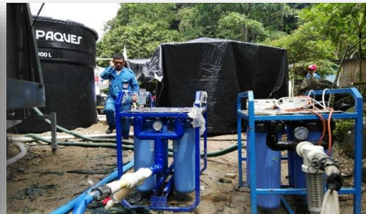
Operación plantas de Agua en la zona.
