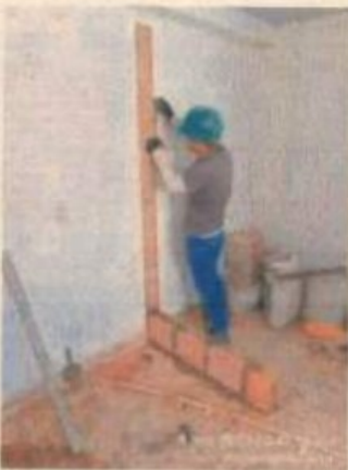
Muro en mampostería, alojamiento segundo piso
