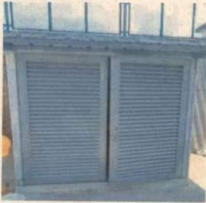
Puerta doble hoja tipo persiana en centro de acopio
