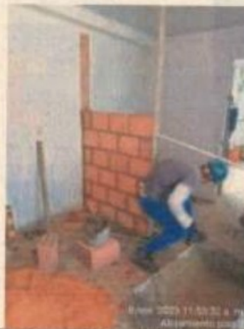
Muro en mampostería, alojamiento segundo piso.
