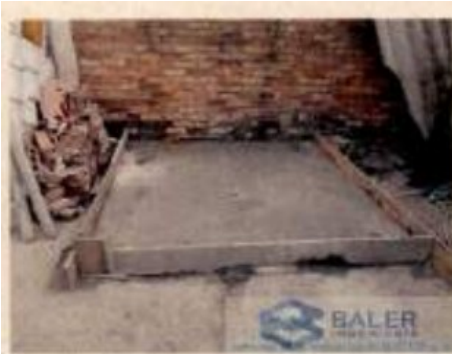
PLACA DE CONTRAPISO EN CENTRO DE ACOPIO
