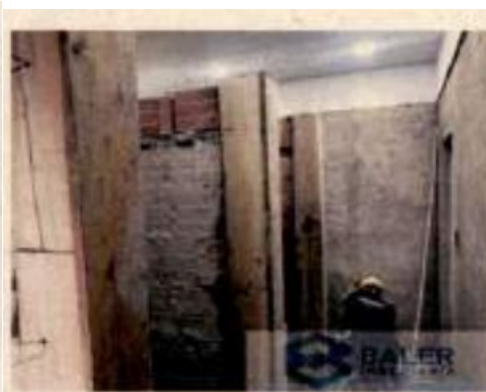
ENCOFRADO DE COLUMNETAS
