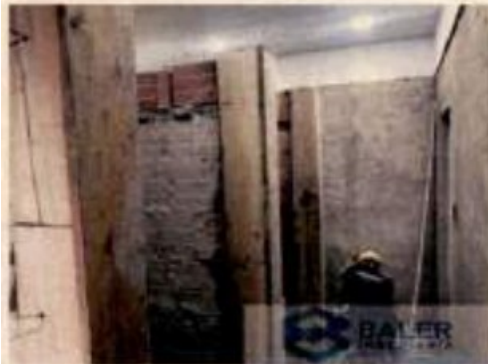
ENCOFRADO DE COLUMNETAS
