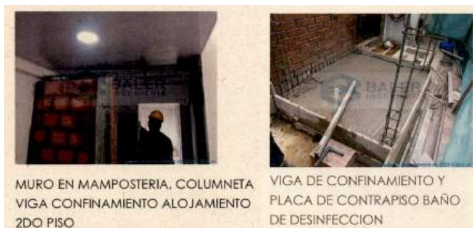
Imagen 9. Registro fotográfico Contrato de obra No. 455 de 2023
