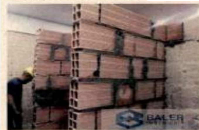
MURO EN MAMPOSTERIA
